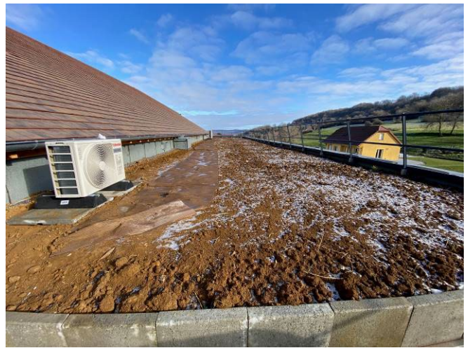
(写真③) 土盛りされたヴァン・ジョーヌのカーヴの天井
