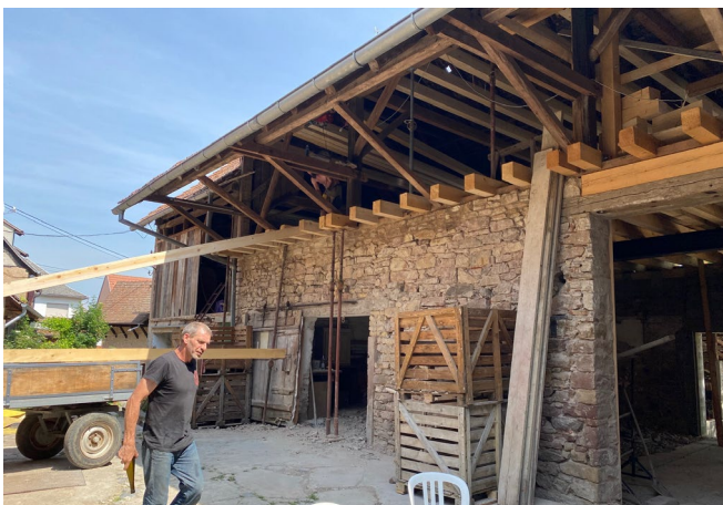
(写真①) エネルギー的な調和も考えながら改築工事
