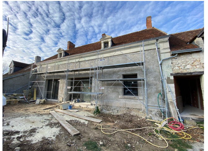
写真②カーヴの目の前に改築工事中のローランの新居
