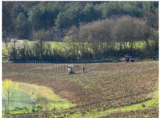
(写真②) 畑に中間柱を打ち込む作業風景
