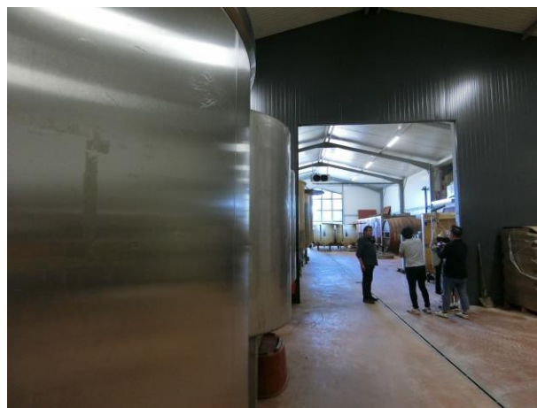
写真② カーヴ右棟内部
