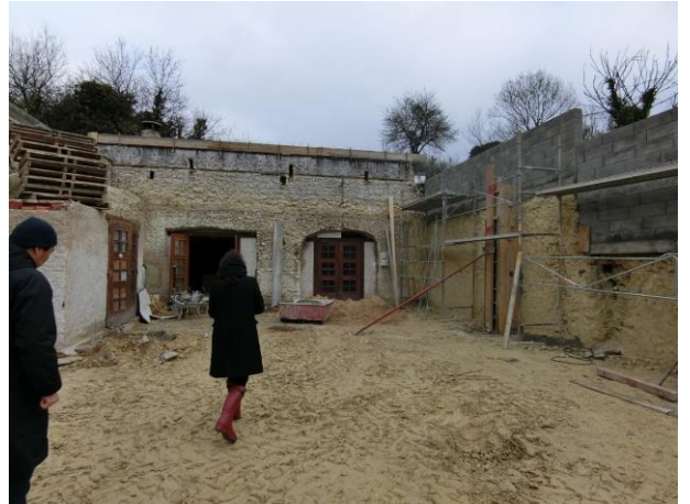
写真② 建設中の新カーヴ
