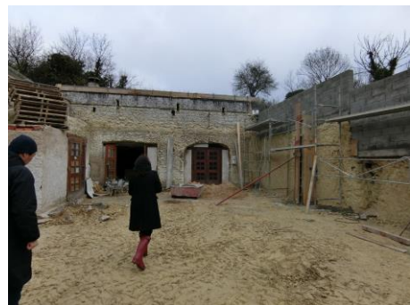
写真② 建設中の新カーヴ
